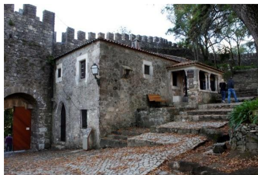
Figura 10 - Fachada do edifício.
