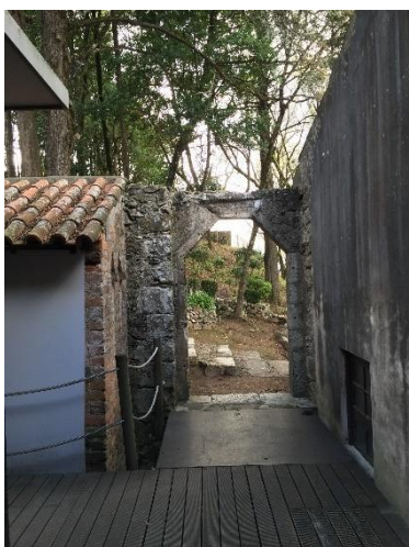
Figura 38 - Fotografia do interior do anexo das casas de banho efémeras.
