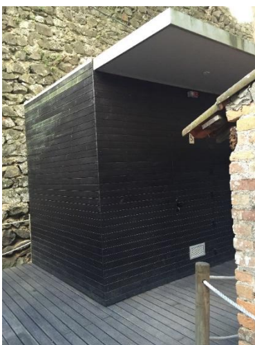
Figura 39 - Fotografia do bloco das casas de banho.
