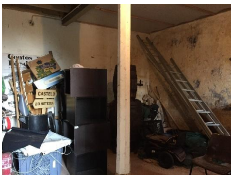
Figura 3 - Fotografia do interior do rés do chão.
