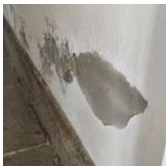
Figura 33. Instalações sanitárias, salitre
