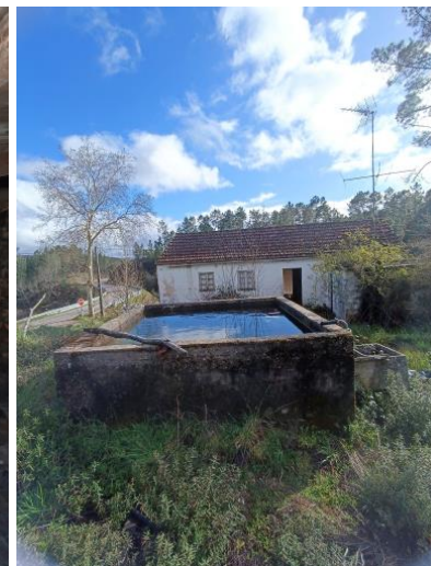
Figura 21 - Espaço Exterior do Edifício
