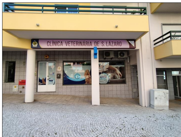
Figura 1 - Fachada exterior da Clínica Veterinária de S. Lázaro
