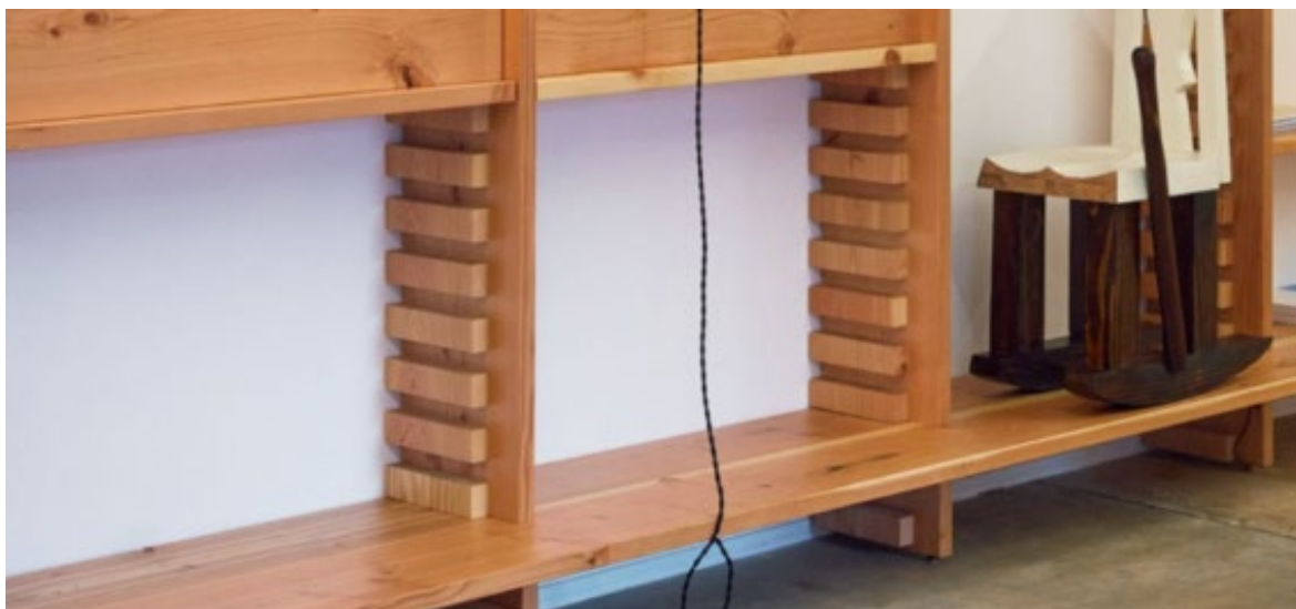
Figura 106 – Imagem aproximada dos encaixes entre as peças estruturais do equipamento. Fonte: André Herrero, 2022
