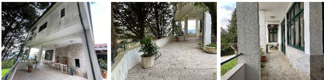
Figura 45 - Acesso à Piscina pelo piso 0. Fotografia: Autora, 2025
