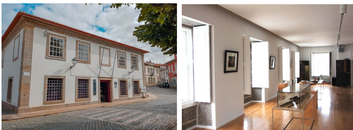
Figura 59 - Edifício da Cadeia. Fonte: Câmara Municipal de Castelo de Paiva, s.d.
