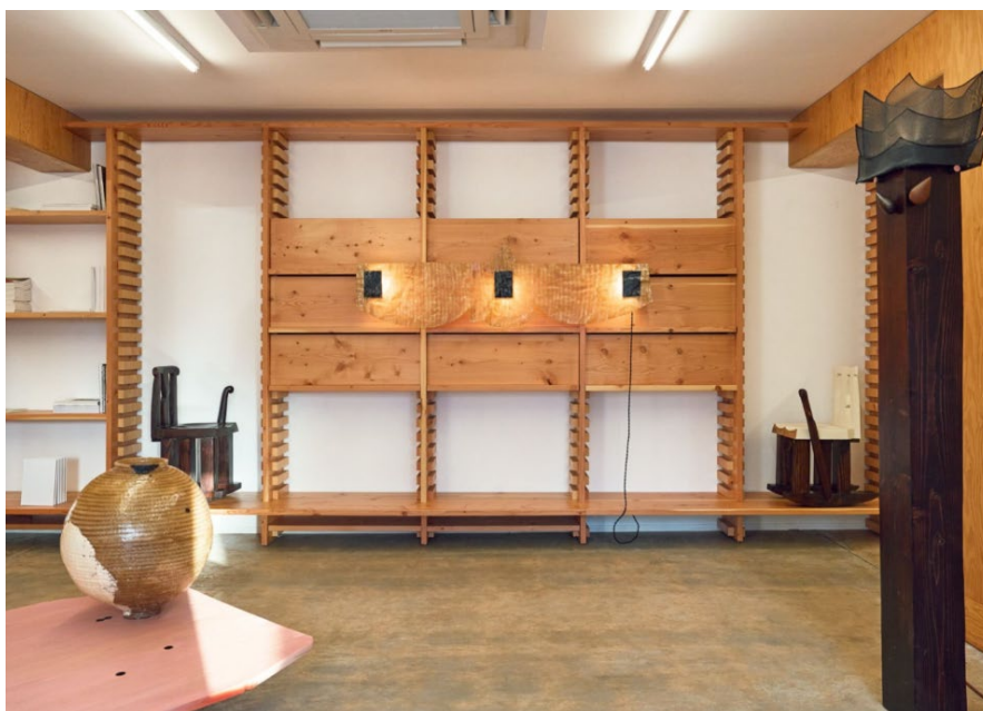
Figura 107 – Vista Frontal, onde as peças que permitem o encaixe das prateleiras, criam uma perspectiva de profundidade. Fonte: André Herrero, 2022
