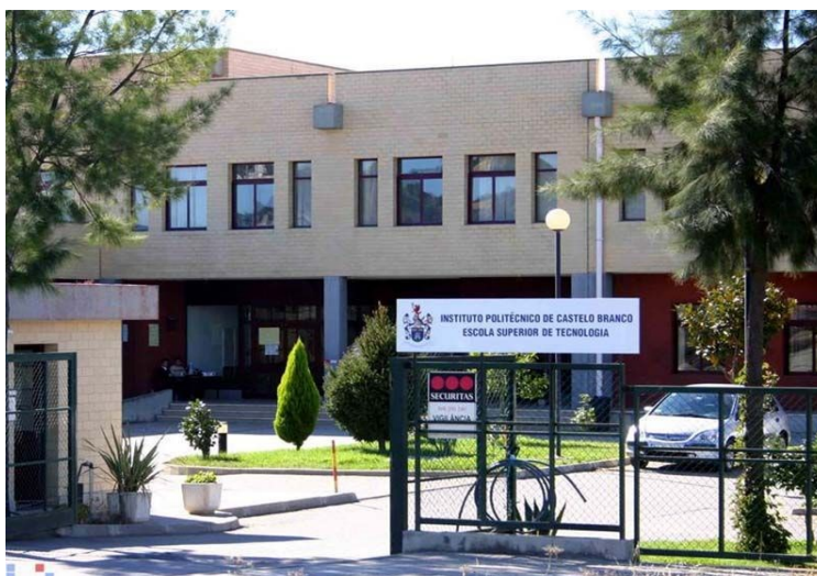
Figure 21 - Escola superior de tecnologia de Castelo Branco, 2025. Photo: Diário Digital Castelo Branco, (2025).
