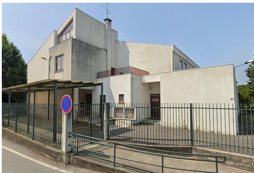
Figura 24- Exterior Escola Eb 1,2 da Valinha Fonte: Google Maps
