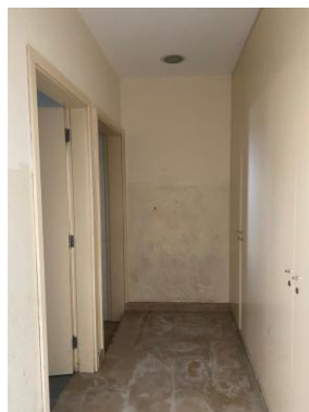
Figura 7 - Entrada das instalações sanitárias Fonte: Autor
