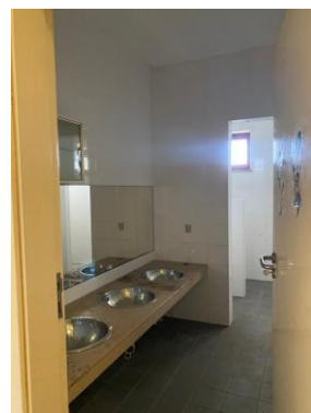
Figura 8 - Instalações sanitárias crianças do pré-escolar Fonte: Autor
