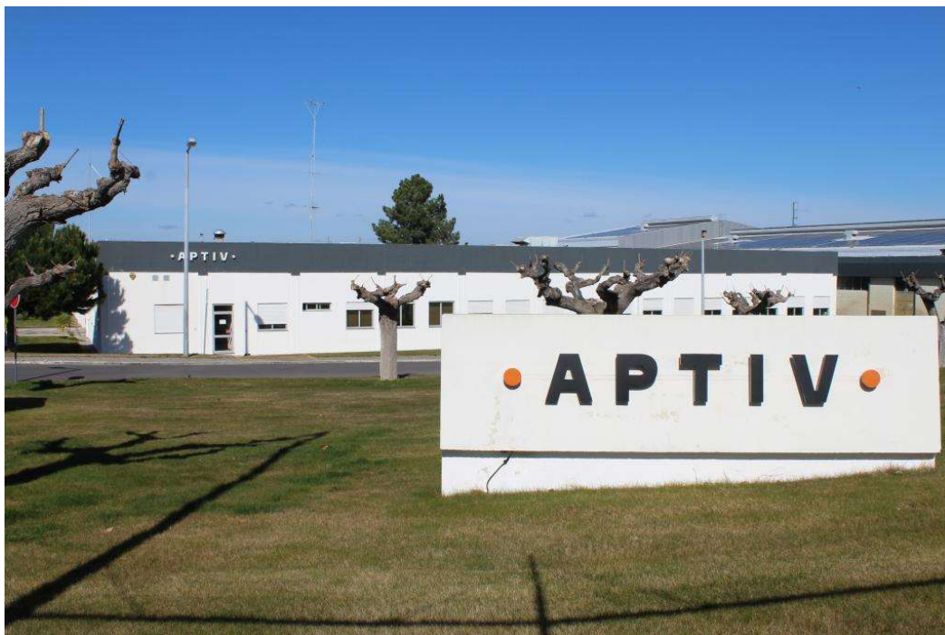
Figura 1 - Fachada APTIV Castelo Branco
