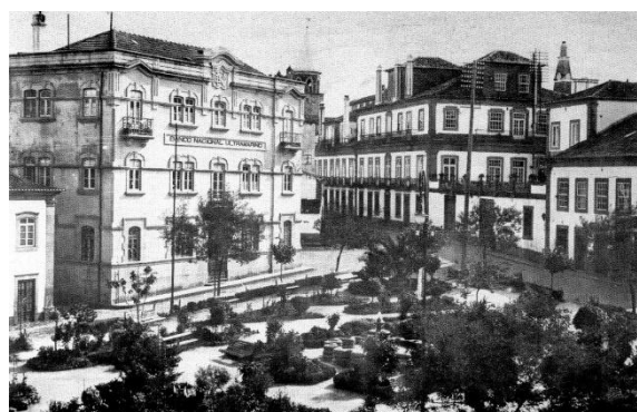
Figura 4 - Vista frontal do edifício, antigo Banco Nacional Ultramarino e o Palacete dos Abrunhosas; Fonte: Jornal “Povo da Beira”
