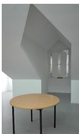
Figura 10 - Pormenor das águas furtadas
