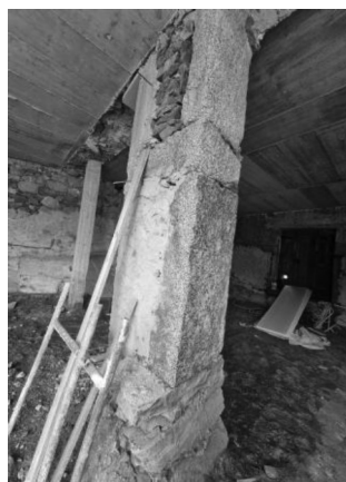
Figura 40 - Detalhe do Pilar nas zonas de transição entre o restaurante e o Bar. Fonte: o Autor
