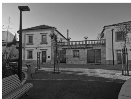
Figura 51 - Sede da Junta de Freguesia de Alcains onde decorreu o encontro Etnográfico. Fonte: Movimento de Associativismo da Beira Baixa
