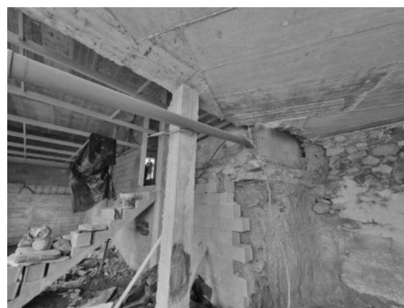
Figura 33 - Levantamento fotográfico da zona do bar. Fonte: o Autor
