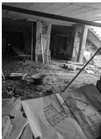
Figura 31 - Verificação das obras já realizadas no espaço. Fonte: o Autor
