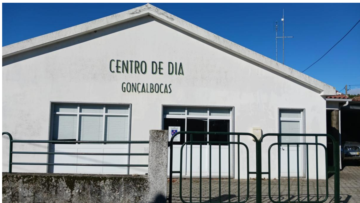
Figura 5 – Fachada Principal do Centro de Dia. Fonte: Pires, A. (Outubro,2025)
