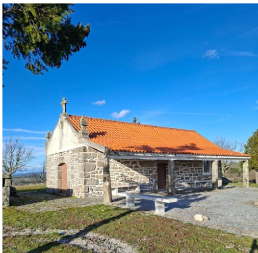
Figura 32 - Capela Santa Bárbara a Leste. Fonte: Pires, A. (Março, 2026)
