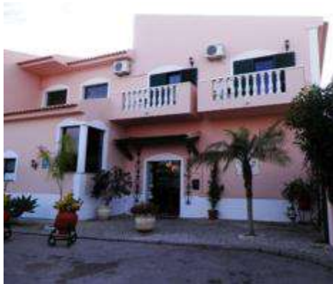
Figura 21 - Fotografia da Fachada Exterior da Entrada 3
