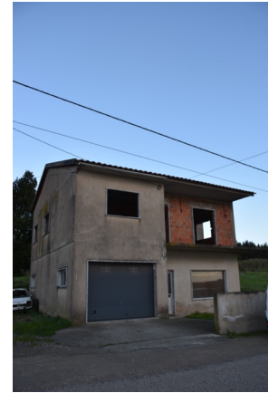
Figura 3- Habitação depois da
