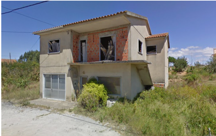
Figura 2 - Habitação antes da intervenção do segundo proprietário 2
