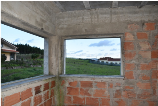
Figura 14 - Fotografia do Existente, Vista para as Janelas da Cozinha 5
