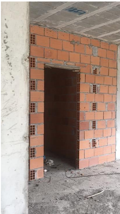
Figura 7- Casa de banho; Fonte: Catarina Costa
