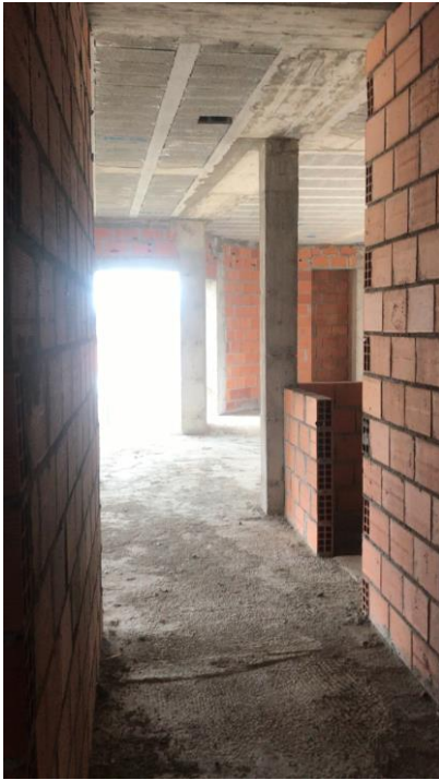
Figura 5- Hall de entrada; Fonte: Catarina Costa
