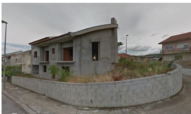
Figura 3- Fachada lateral da Moradia; Fonte: Google Maps
