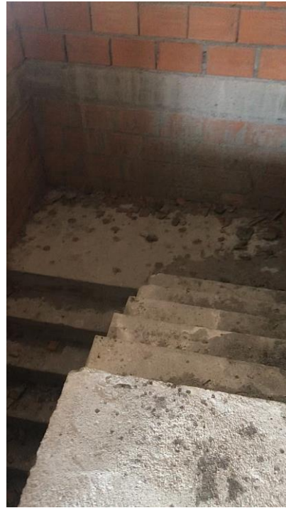
Figura 6- Escadas de acesso à cave; Fonte: Catarina Costa
