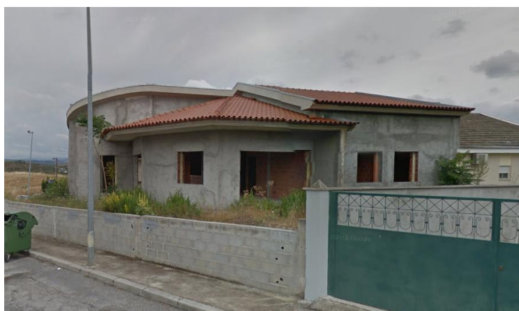
Figura 4- Fachada lateral da Moradia; Fonte: Google Maps
