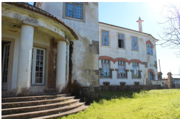
Figura 12- Zona exterior da parte principal.
