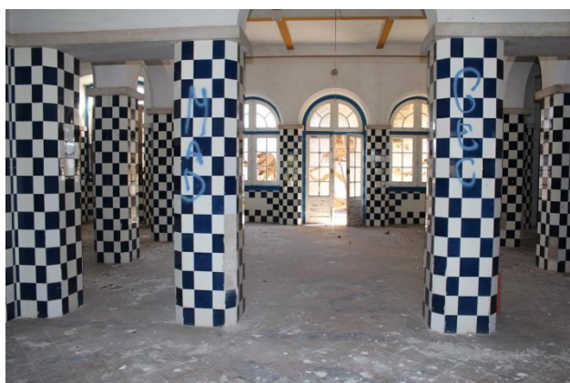
Figura 10- Zona central do edifício
