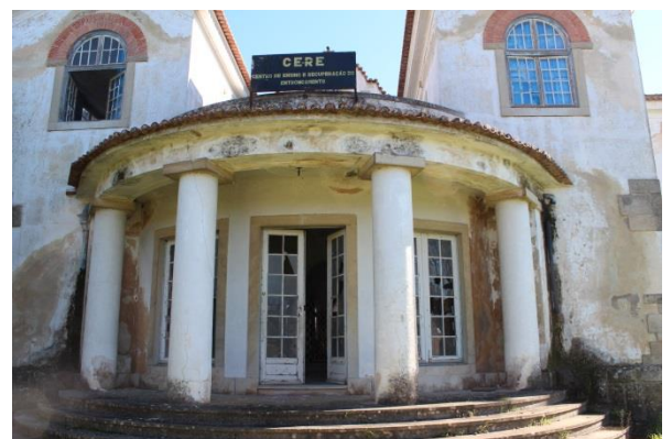
Figura 3 - Entrada principal de acesso ao interior
