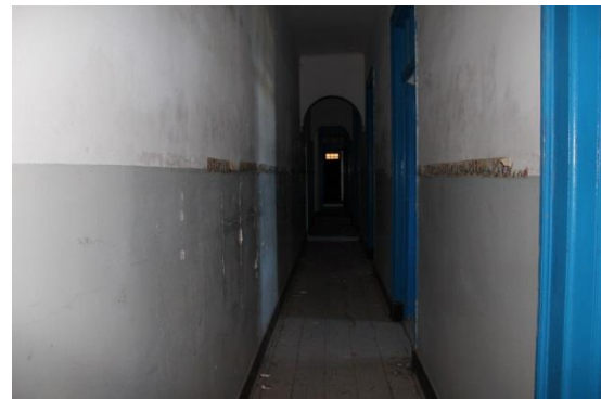
Figura 23- Corredor do piso 1
