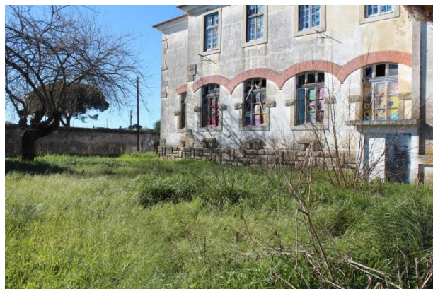
Figura 13- Zona exterior da parte posterior.
