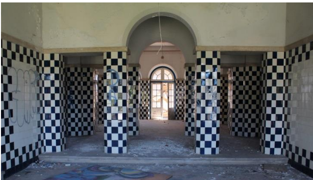
Figura 22- Entrada do edifício
