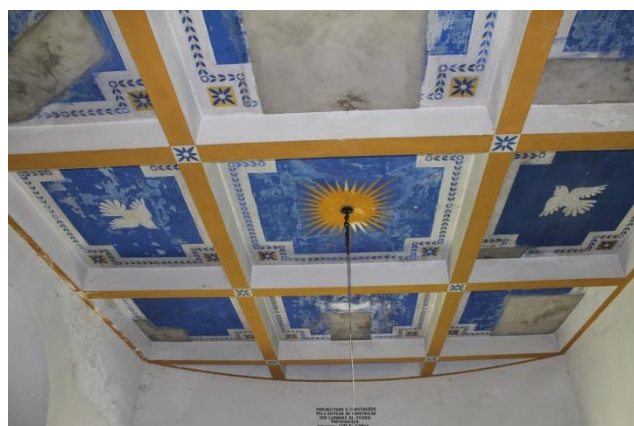
Figura 9- Teto da zona de entrada
