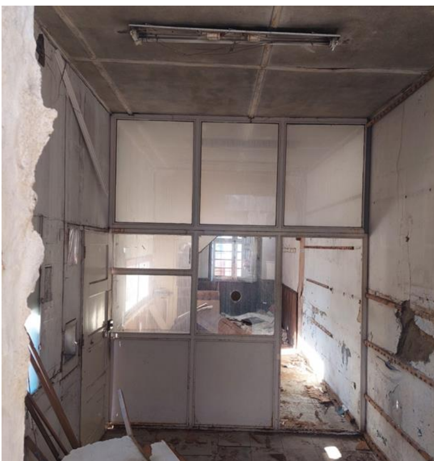
Figura 7. Parede interior do edifício. Fonte: autora, (2023).
