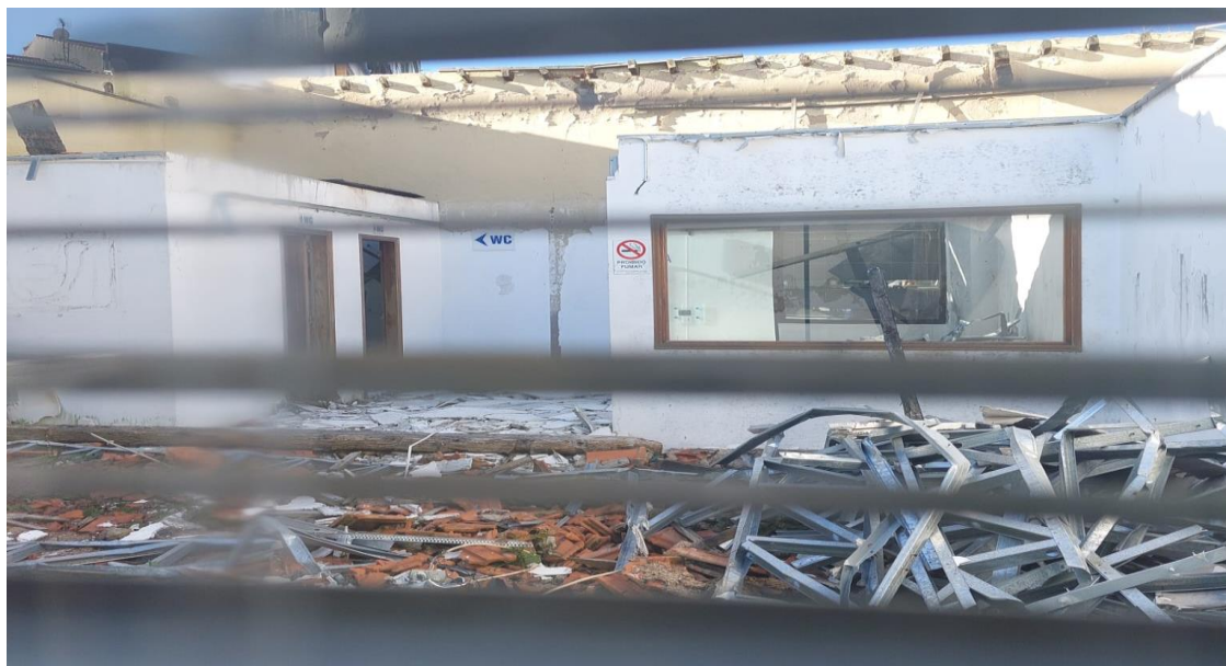
Figura 6. Interior do edifício. Fonte: autora, (2023).
