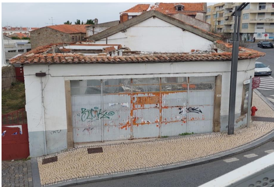
Figura 4. Frente do edifício. Fonte: autora, (2023).
