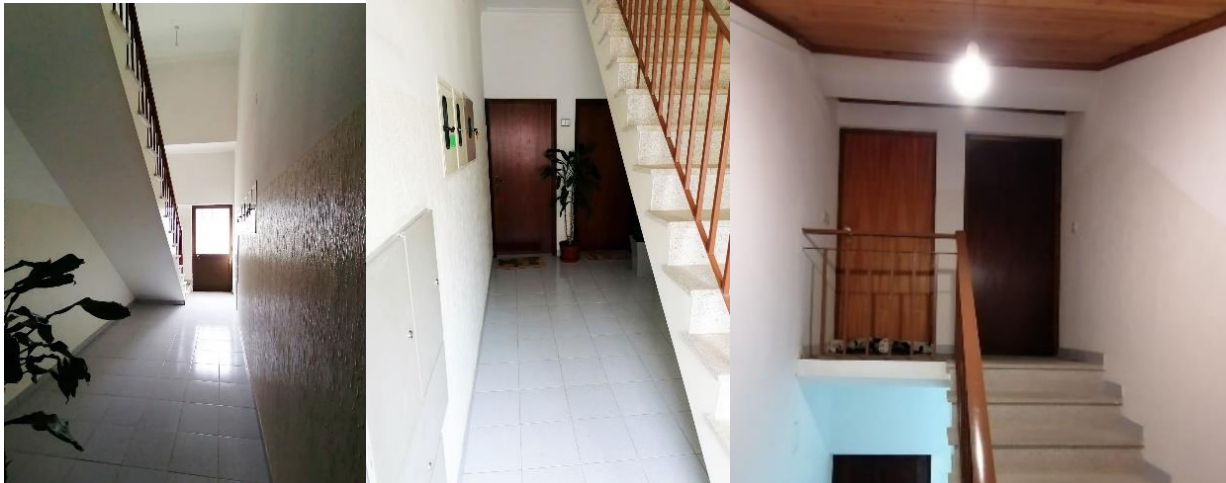
Figura 33 - Zona de entrada e escadas
