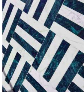
Figura 27- Pavimento das WC'S
