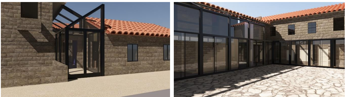
Fig.2 - Estrutura metálica envidraçada
