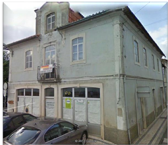
Imagem 2 - Fachada principal do espaço destinado à clínica dentária
