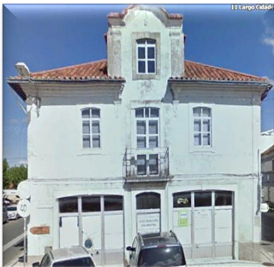
Imagem 1 - Fachada principal do espaço destinado à clínica dentária
