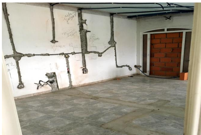
Figura 3 – Fotografia Vista lateral
