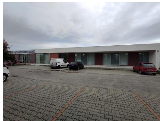
Figura 13- Fachada do Edifício: Vãos. Fonte: Autora
