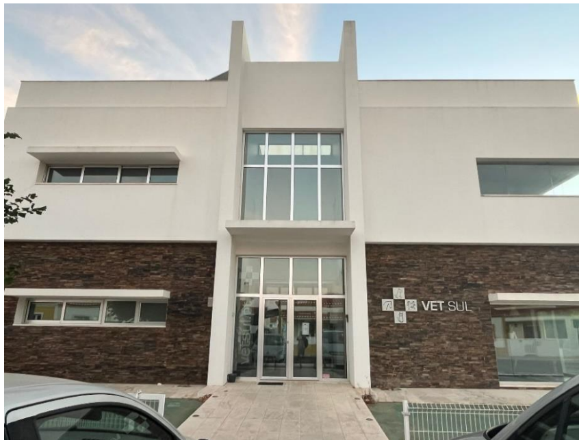
Figura 1 - Instituto Veterinário VETSUL
