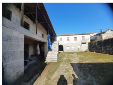
Figura 5 - Casa do Outeiro, Área exterior, Fonte: Autor
