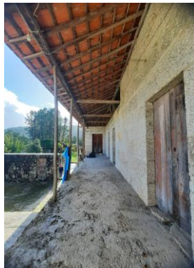
Figura 14 - Casa do Outeiro, varanda/corredor piso 1, Fonte: Autor
