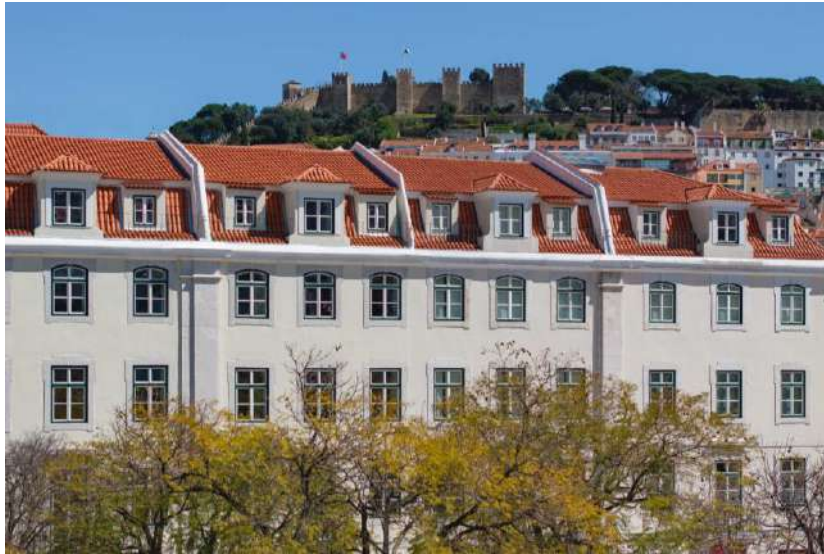
Figura 45 Apto Pombalinos -gabinete de arquitetura Intergaup e engenharia da LNM, Foto: KALAM, Consultado a 20\03\2026
