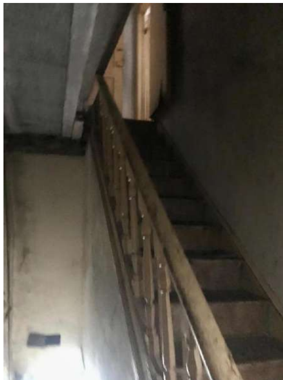
Figura 14 Escadas de acesso ao apartamento (fonte: Vander Costa, 2025)
