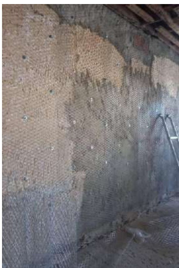
Figura 48 Apto Pombalinos -gabinete de arquitetura Intergaup e engenharia da LNM, Foto: KALAM, Consultado a 20\03\2026
