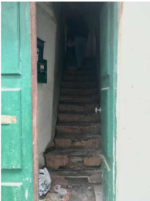
Figura 13 Entrada principal do prédio (fonte: Vander Costa, 2025)
