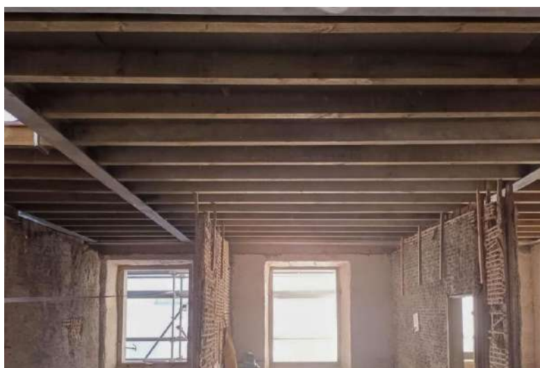
Figura 49 Apto Pombalinos -gabinete de arquitetura Intergaup e engenharia da LNM, Foto: KALAM, Consultado a 20\03\2026
