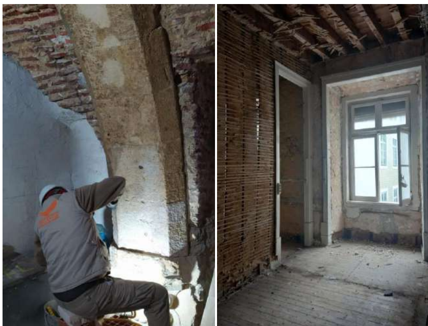
Figura 47 Apto Pombalinos -gabinete de arquitetura Intergaup e engenharia da LNM, Foto: KALAM, Consultado a 20\03\2026
