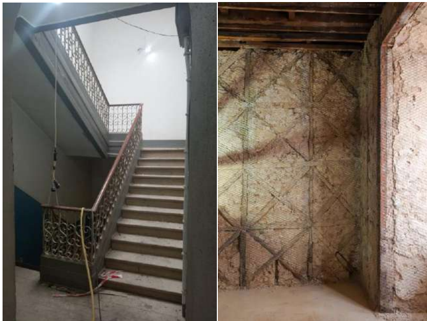
Figura 46 Apto Pombalinos -gabinete de arquitetura Intergaup e engenharia da LNM, Foto: KALAM, Consultado a 20\03\2026
