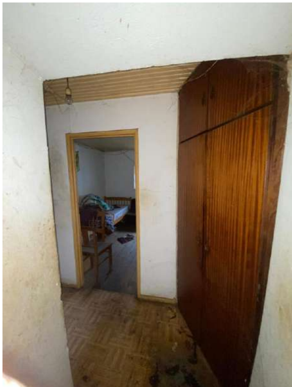
Figura 25 Entrada do terceiro quarto (fonte: Vander Costa, 2025)
