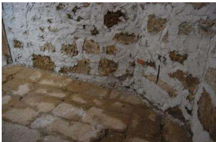
Figura 32 Aplicação de revestimento (fonte: Universidade do Porto, 2014)
