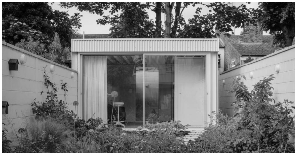
Figura 23-Atelier do Projeto Casa Pátio Branco , fotografia de Stijn Bollaert (Arch Daily, Publicado a 20 de Abril de 2023) https://surl.li/ieyjyf
