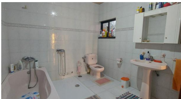
Figura 12- Instalação Sanitária (Fonte: autora, 2026)
