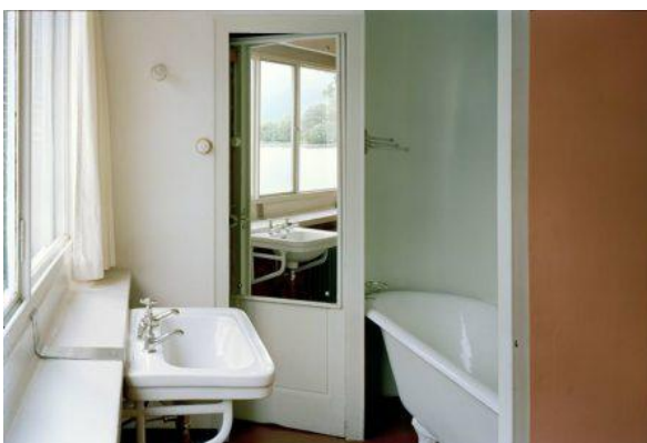
Figura 43- instalação sanitária (Gambier, 2005)
