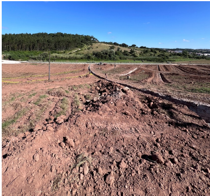
Figura 7- Instalação do sistema de drenagem.
