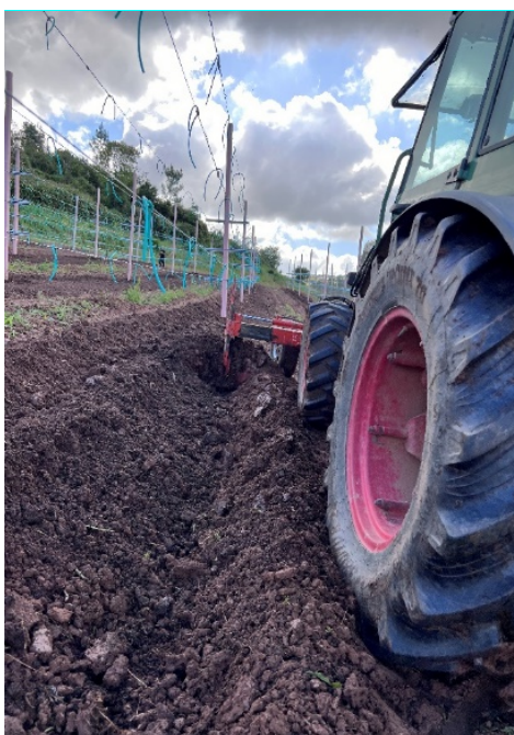
Figura 12- Abertura da vala de plantação.
