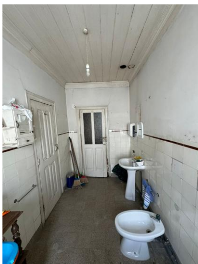
Figura 23- Instalações Sanitárias Fonte: Autor
