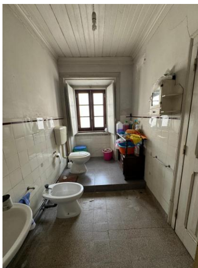
Figura 22 - Entrada Instalações Sanitárias Fonte: Autor
