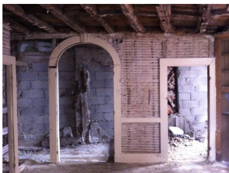
Figura 50 - Construção de paredes em tabique Fonte: Meet me on the second floor
