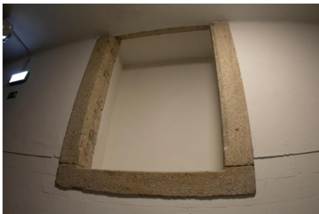
Figura 49 - Imagem de uma antiga janela do edifício existente posteriormente à fábrica da criatividade-
