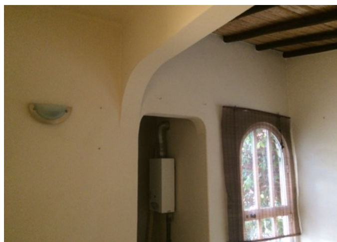
Fig. 30 - Zona de arrumos, visualização de viga;
