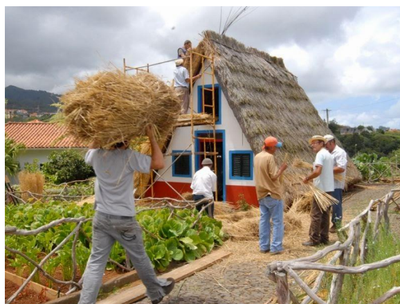
Figura 11 – Montagem do colmo; Fonte: Somos Madeira.
