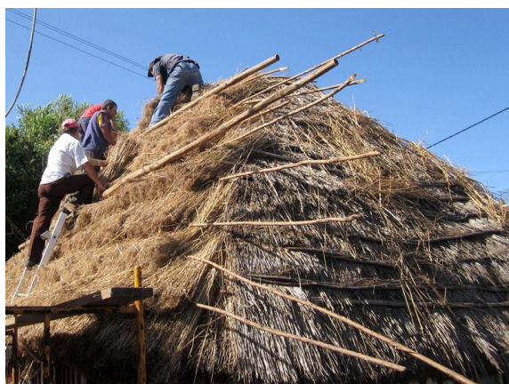
Figura 12 – Colocação das varas durante a colmatção; Fonte: Santana Madeira Biosfera.
