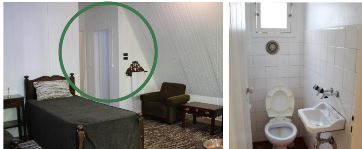
Figura 77 – Instalação sanitária existente, Alojamento Loureiro, Piso 1.
