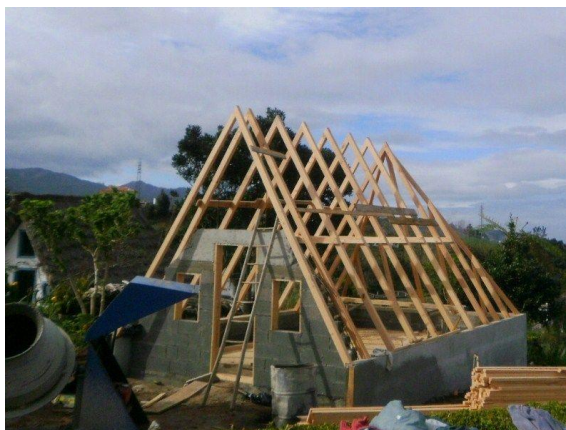
Figura 9 — Armação da madeira com asnas e madres; Fonte: Santana Madeira Biosfera.
