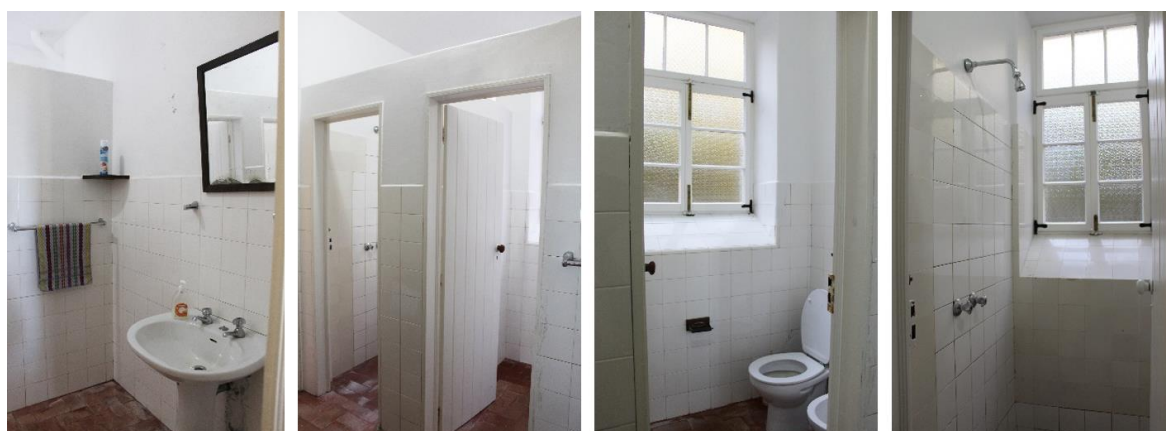
Figura 35 – Piso 0, instalações sanitárias, ano de 2021.
