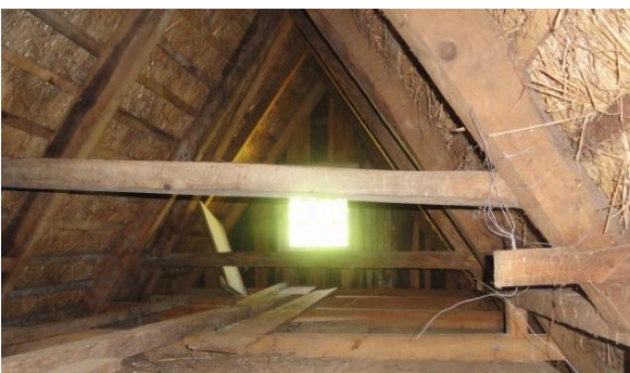
Figura 47 – Piso 2 sótão, estrutura da cobertura constituída por asnas, varas e madres, ano de 2021.
