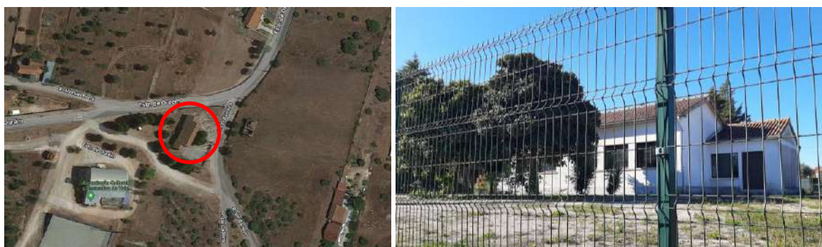
Figura 1 e 2 - Localização e Fachada Principal da Escola Primária
