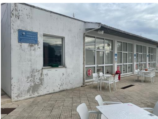
Figura 55- Acesso à Esplanada
