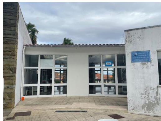
Figura 54- Acesso à Esplanada
