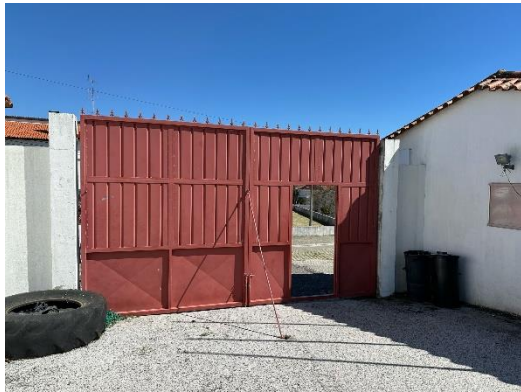
Figura 3 - Saída de Emergência
