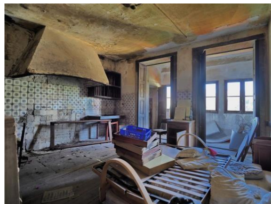
Figura 18. Cozinha divisão do terceiro andar
