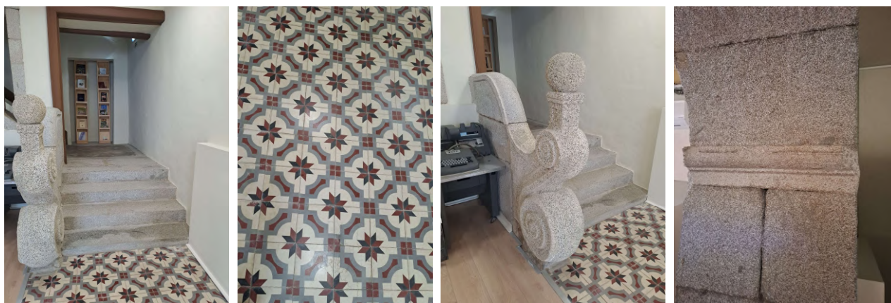
Escadaria e Corrimão em Granito no piso 0
