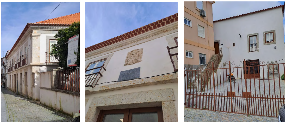
Figura 7 - Conjunto de Fotografias do Exterior do Edifício (Fachada Frontal, Brasão e Fachada Posterior) - Fonte: Bruna Monteiro
