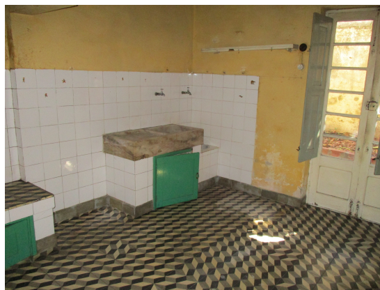
Figura 8 — Cozinha com acesso ao logradouro;
