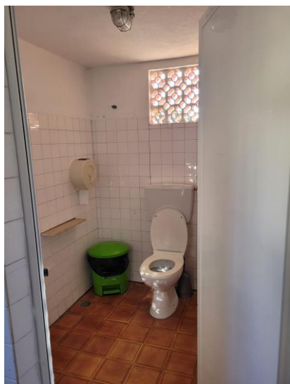
Figura 14 - Instalação Sanitária, do autor.
