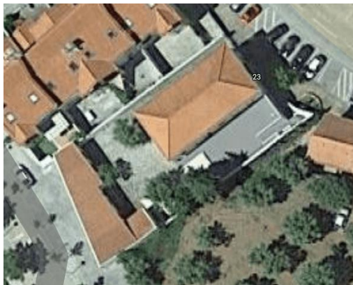
Fig. 5 Vista satélite do edifício
