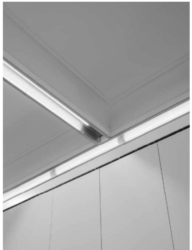
Figura 27 – Detalhes do teto
