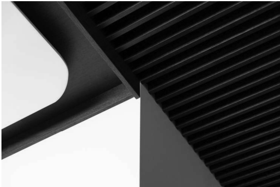
Figura 20 – Detalhe em madeira no teto, fotografado por Carlos Eduardo Vinagre.
