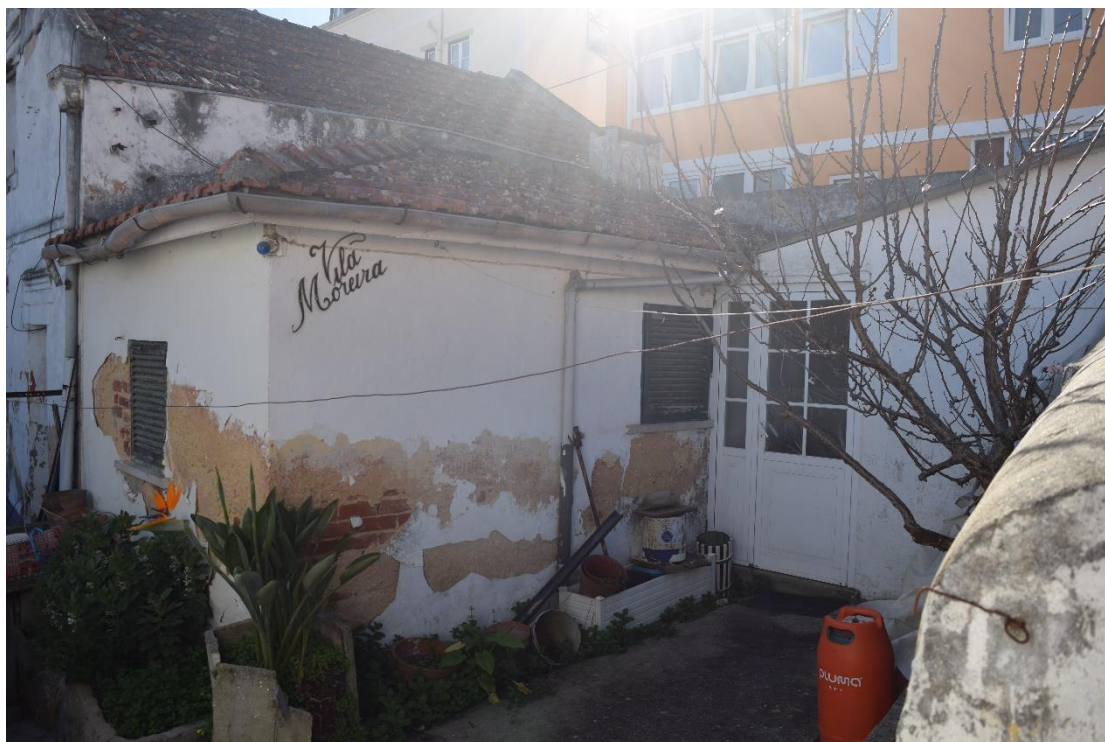
Figura 1 Fotografia do exterior da habitação
