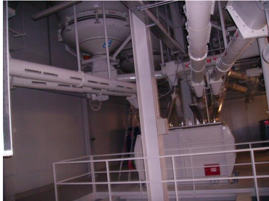
Fotografia 1 Doseamento automático conforme a receita
