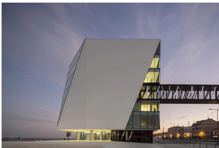
Figura 28: Vista exterior da Biblioteca Municipal de Vila Franca de Xira ao entardecer, evidenciando o volume suspenso e a relação com a frente ribeirinha. Fonte: Arruda Arquitectos Associados (2020).
