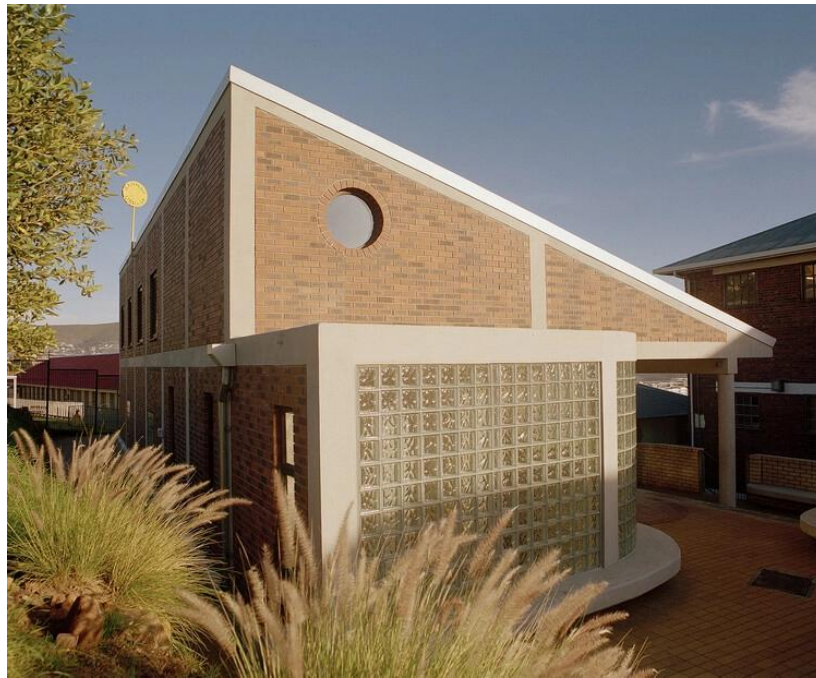
Figura 18: Fachada da Biblioteca Rahmah, com tijolos produzidos a partir de argila local. Fonte: The MAAK (2025).
