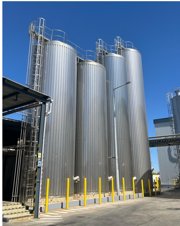
Figura 14: Silos de leite (Receção de leite)
