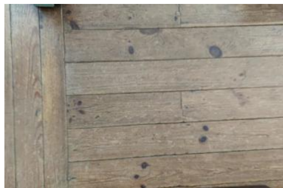
Figura 22 - Pormenor pavimento Piso 1. Foto de Autor, 2022
