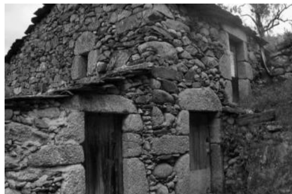
Figura 13 - Casa típica de Loriga em granito. Foto de Paulo Juntas. Fonte: Wikipédia
