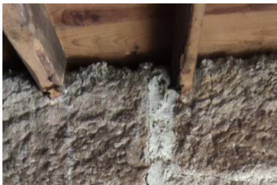
Figura 23 - Paredes interiores Piso 0. Foto de Autor, 2022
