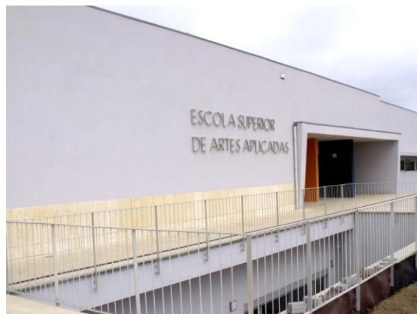
Figure 3.20 - Escola superior de Artes Aplicadas de Castelo Branco, 2018. Photo: Diário Digital de Castelo Branco (2018).
