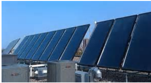
Figura 3: Coletores solares CPCs utilizado em sistemas de aquecimento de alta eficiência.
