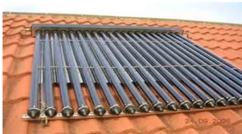
Figura 4: Coletor solar de vácuo para aquecimento de água em sistemas residenciais e industriais.
