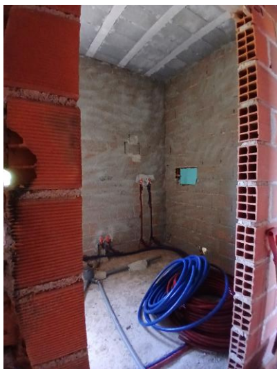
Figura 14 - Instalação sanitária de apoio aos quartos, Fonte: Autora (2026)
