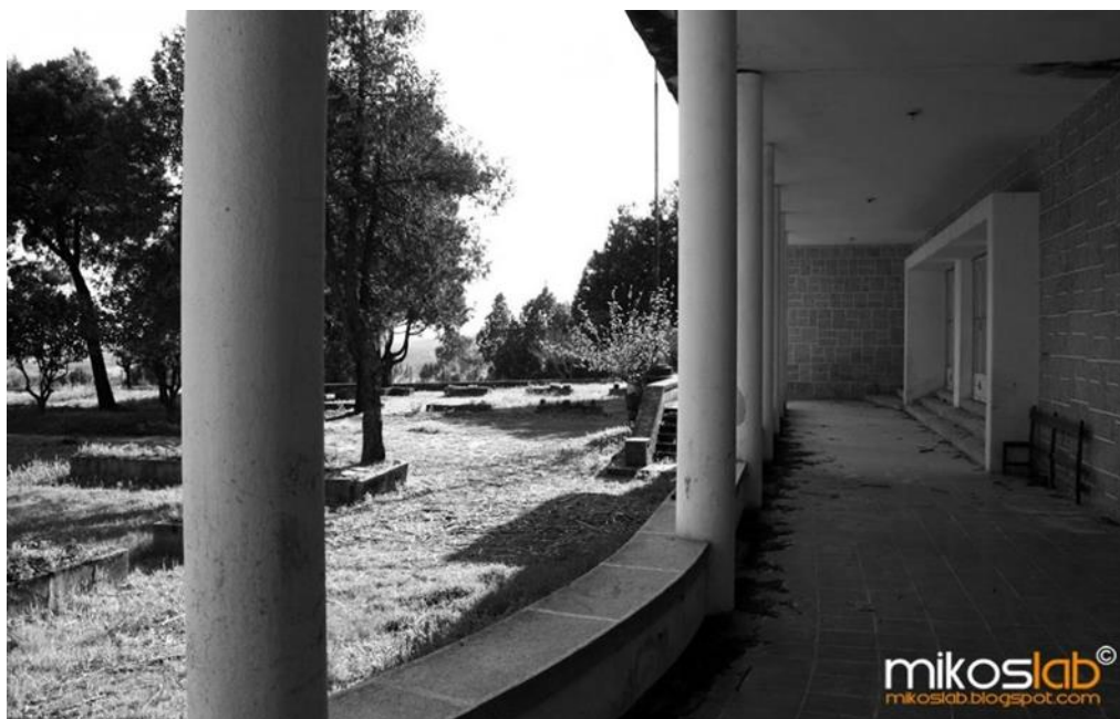
Figura 10, 11 e 12: Fotografia do espaço antes do incêndio - Exterior, sala e casa de banho; Fonte mikoslab.blogspot;
